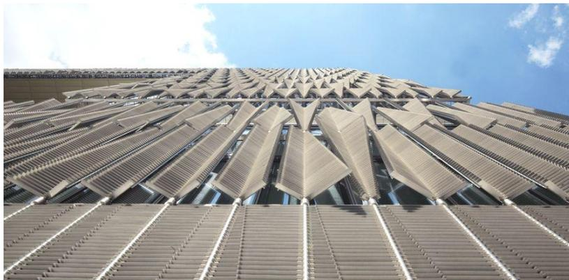
**Рис. 2. Муниципальное здание с вентилируемым PV-фасадом в Испании**
