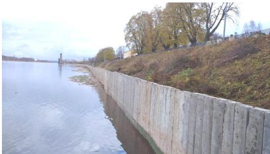
**Рис. 1. Укрепление берега с помощью железобетонного шпунта**
