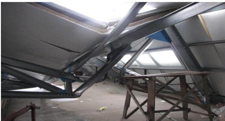
**Рис. 2. Обрушение конструкций покрытия коровника
