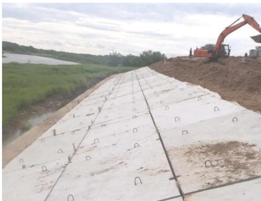
**Рис. 2. Укрепление берега сборными железобетонными плитами**
