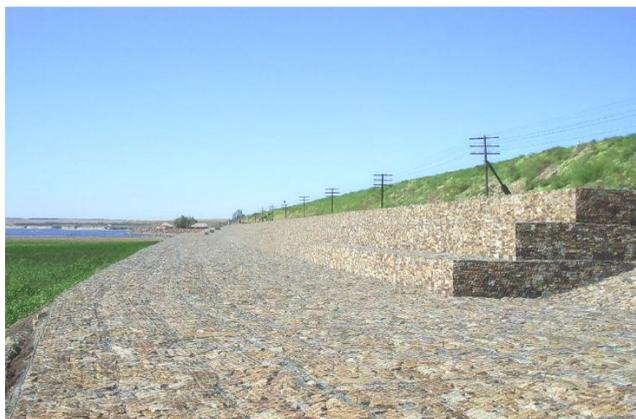
**Рис. 3. Укрепление берега матрасами Рено и коробчатыми габионами**
