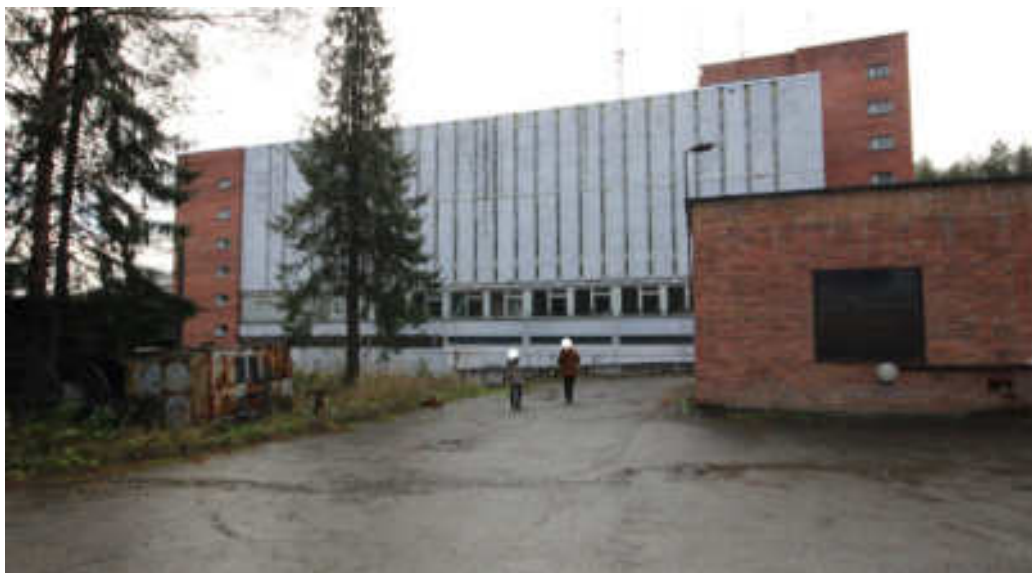
Рис. 1. Здание АТС в городе Нижняя Тура
