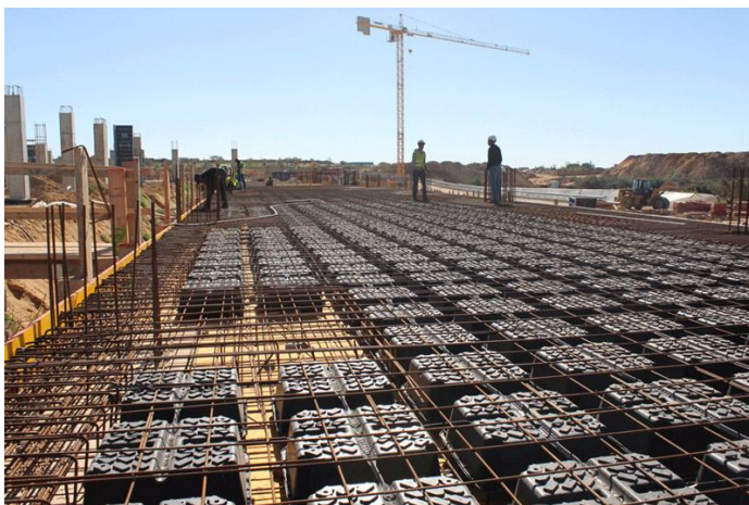
Рис. 4. Конструкция плиты DaliformGroup
