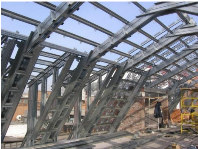
Рис. 1. Конструкция из ЛСТК-профилей
