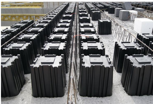
Рис. 1. Конструкция плиты Airdeck
