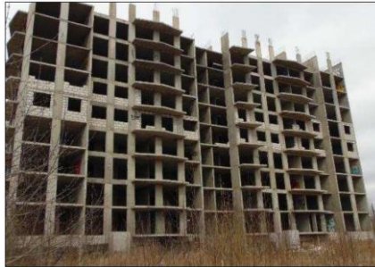
Рис. 3. Частичная кладка наружных стен из газосиликатных блоков
