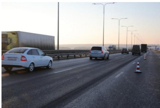
**Рис. 1. Колея на автомобильной дороге М4 «Дон» [1]**
