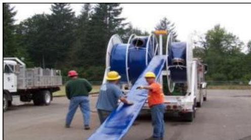
**Рис. 3. ГПР диаметром 400 мм в бухте**
