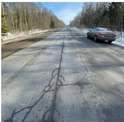
**Рис. 4. Участок дороги с продольной трещиной Ярославская область**
